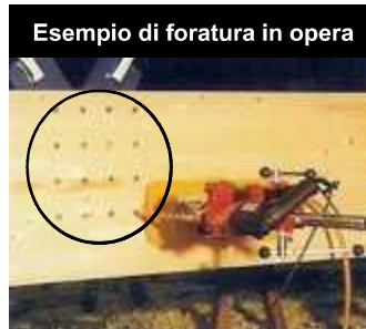
Lama in ferro inserita nel legno
